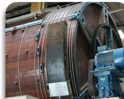
КОЖЕВЕННЫЙ ЗАВОД ПАТРИОТ, РЕЗЕРВУАР 2022г., г.БОГОРОДСК, НИЖЕГОРОДСКАЯ ОБЛАСТЬ
