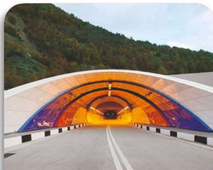
РОКСКИЙ ТОННЕЛЬ 2015г., СЕВЕРНЫЙ КАВКАЗ
