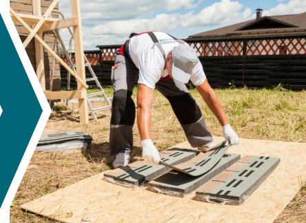
Перемешивание фасадной плитки
